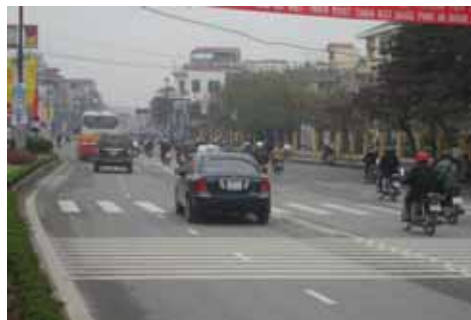
Tuyến đường Trần Khát Chân - Đại Cồ Việt
