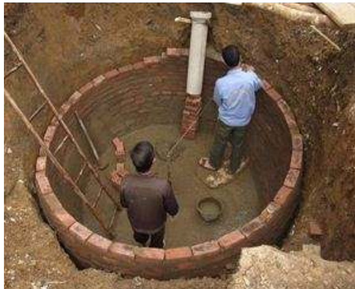
Xây dựng hầm bi-ô-ga bằng gạch ở bản Tia Ghén C
