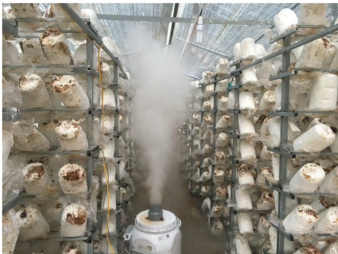
Lắp đặt máy tạo độ ẩm trong nhà nấm
