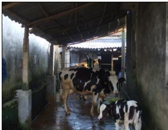
Dựng lại toàn bộ mái chuồng bằng cột bê-tông và tôn ximang (công trình hơn 10 triệu – trại nhà ông Hà -VT)
