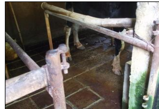
Sàn chuồng đã được tạo rãnh để chống trơn trượt (Trại nhà anh Phong-VT)
