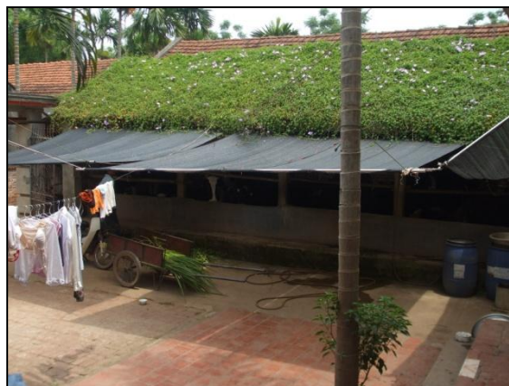
Lắp thêm hệ thống mái cuốn tự động để hạn chế nhiệt hắt vào chuồng (nhà ông Thành-VT)
