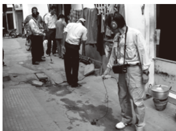
探知機で漏水音を調べる様子(カンボジア)も収録されている
