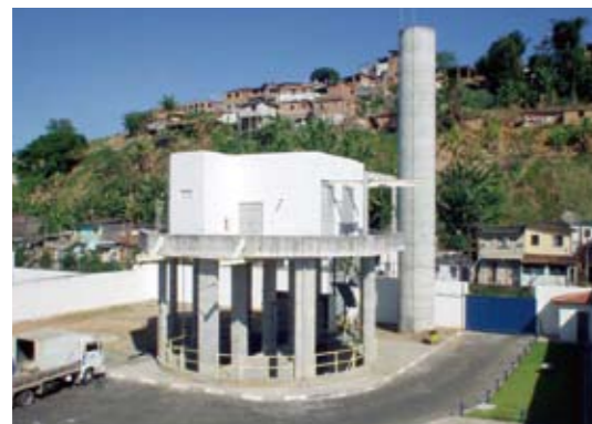
円借款で整備された下水道施設
