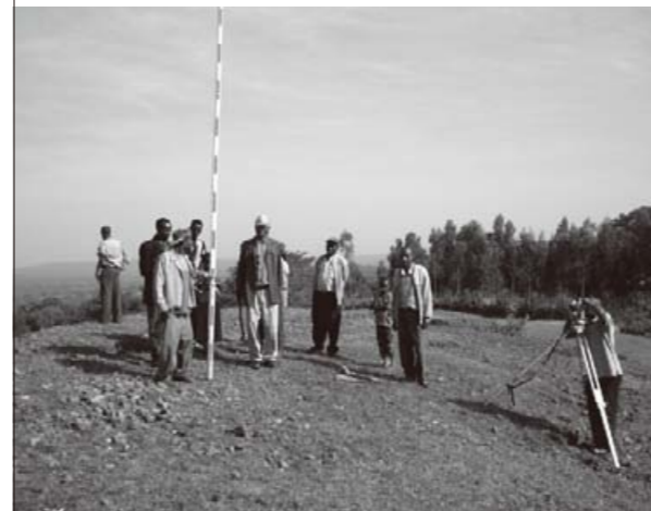
給水施設の建設予定地で測量を行う現地スタッフ。最近、セメントやパイプなど資材の高騰も問題となっている
