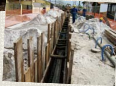
サンパウロ州沿岸部で進められている下水道の配管工事
