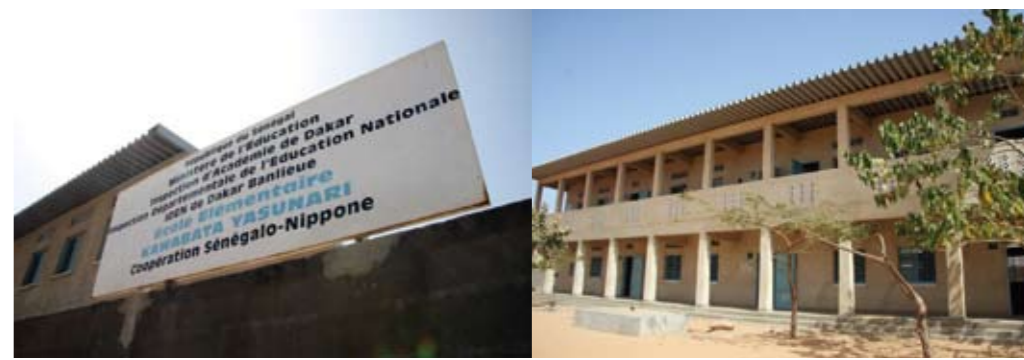
日本の無償資金協力により建設された「カワバタヤスナリ小学校」。ダカールの市街地にあり敷地の確保が難しいため、2階建て様式が選ばれた
