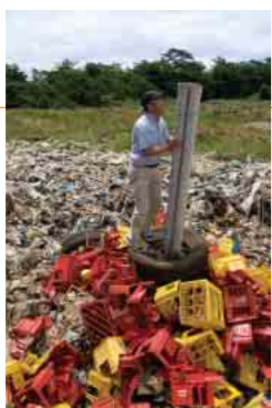
ガス抜き管と発生ガスを点検する天野さん(右)。「先端から浸出水が吹き出て、スプーン状の金具を当たって足元のろ過装置に拡散します」とごみから出た汚水を処理する原理を説明(下)
