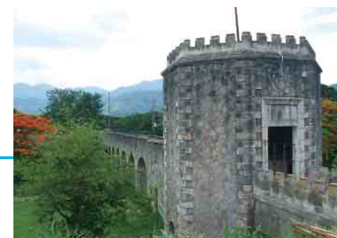
キングストン近郊の川と貯水池を結ぶ導水路。英国統治時代の18世紀半ばに建設された。こうした古い施設の不十分な維持管理が、無取水率の高さの一因となっている
