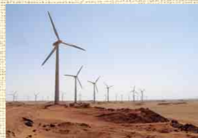
風力発電の盛んなザファラーナ地区。JICAはエジプト最大規模の風力発電施設の建設を支援
