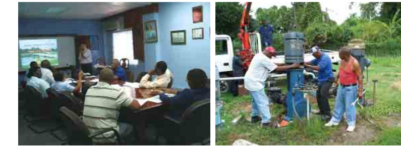
(上) 円借款で改修されたキングストン首都圏スパニッシュタウン地区の浄水場。以前より多くの水を供給できるようになった (左) 浄水分野の専門家を育成する研修で、講義する大坂さん (右) 故障した給水施設のモーターを交換するNWCの職員。「据え付け方や使用する工具などにまだまだ改善が必要」と大坂さん
