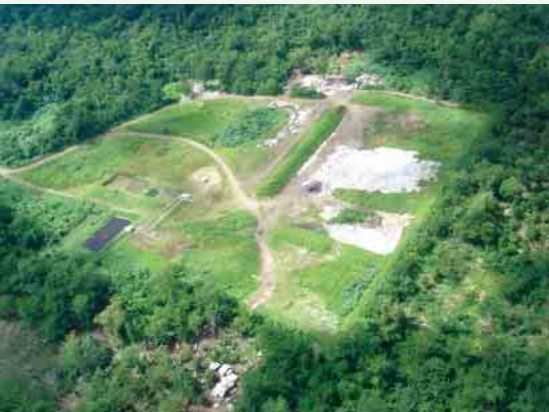
悪臭が漂い、危険で不衛生だった埋め立て処分場がごみの分解を促進する衛生的な処分場に改善された(サモア)
