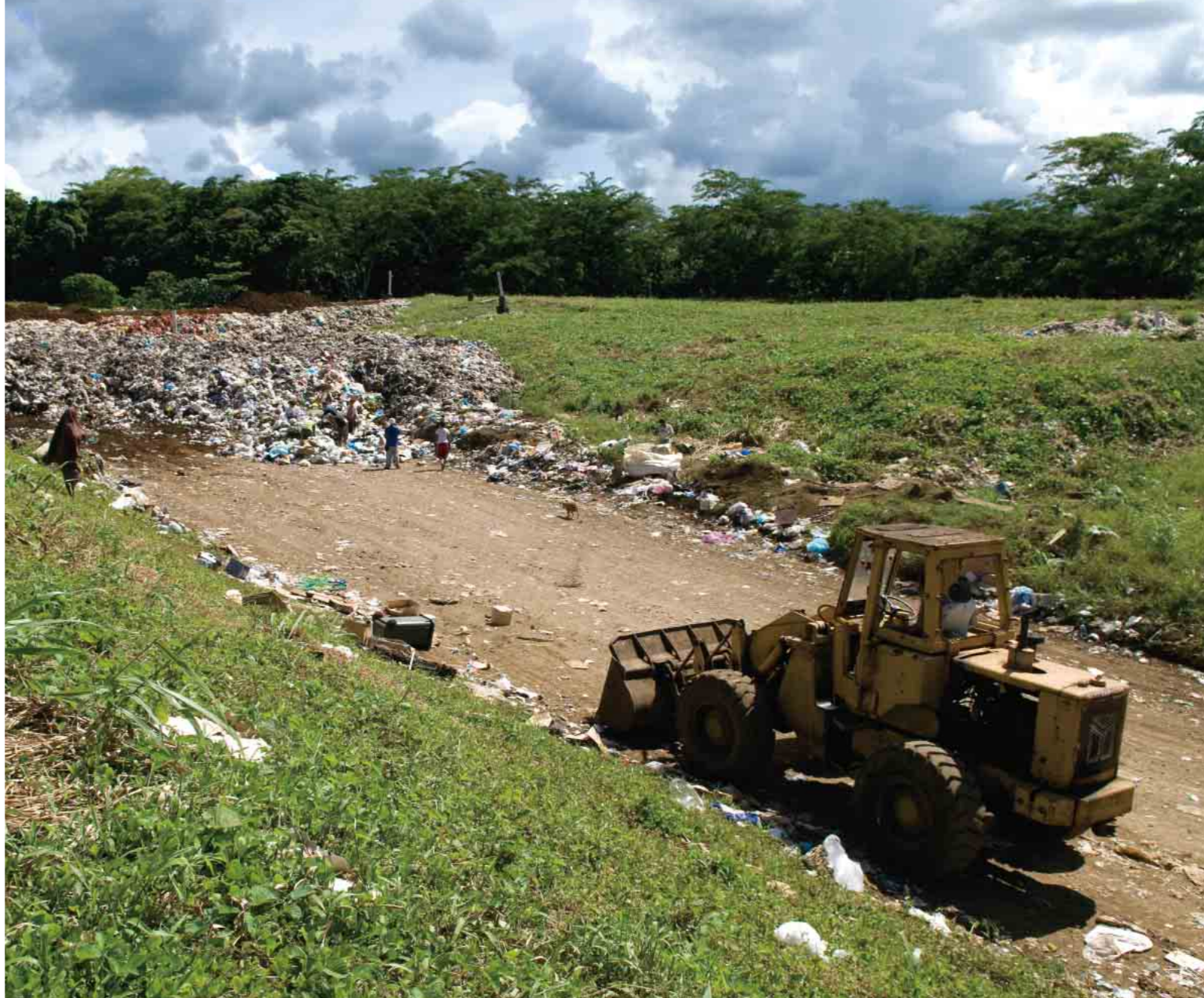
「福岡方式」を取り入れ、改善されたサモアのタファイガタ処分場。ごみ収集車が到着すると、まずウェストピッカーがごみの中から有価物を探す。その後、重機でごみを一カ所に集め、踏み固める
