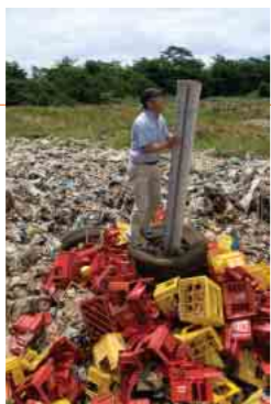
ガス抜き管と発生ガスを点検する天野さん(右)。「先端から浸出水が吹き出て、スプーン状の金具に当たって足元のろ過装置に拡散します」とごみから出た汚水を処理する原理を説明(下)
