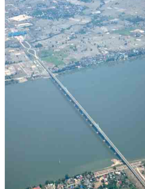
円借款としては、初めての2国間にまたがる広域インフラ整備となった第2メコン国際橋の建設。日本の企業を中心に、タイ・ラオス両国の企業や技術者が参加して工事が進められた
