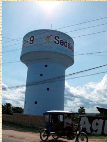
アマゾン流域の町イキトスに建てられた給水塔
