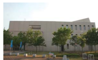
兵庫県こころのケアセンターのある「HAT神戸」は、震災で倒壊した工場の跡地を利用して開発された
