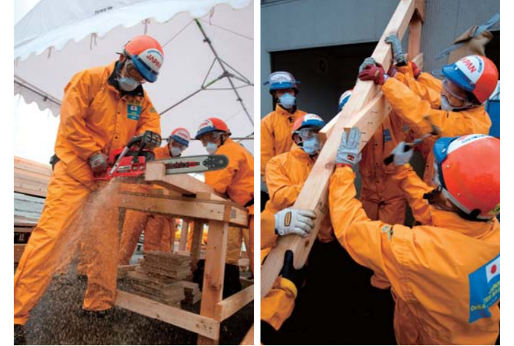
ショアリングでは、木材を切断してパーツを作り(左)、組み合わせる角度や打ち込むくぎの位置などに注意しながら支柱を設置していく(撮影:久野真一)
