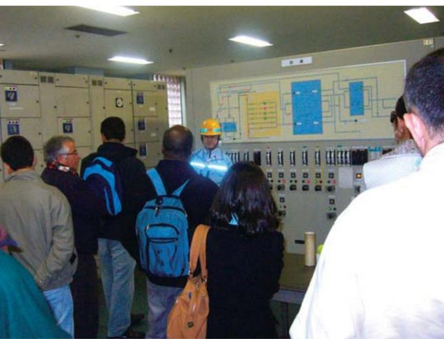
配水ポンプ場の制御装置。ここで、市内へ送られる水道水の水量と水圧などをコントロールしている
