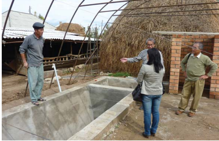
最も製造コストの低いカナル型バイオガスプラントの建設現場を視察
