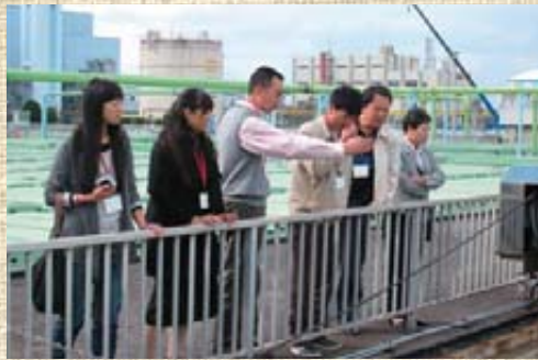
北九州市にある浄化センターでの研修で、汚水処理について学ぶ雲南省関係者
