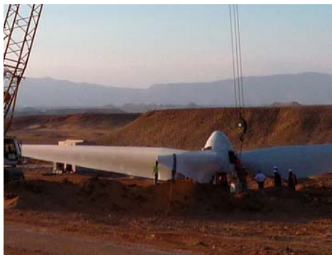
(上)タービンの土台を建設中 (下)羽根部分を組み立てる作業員。羽根と支柱を合わせると高さは81メートルにも上る
