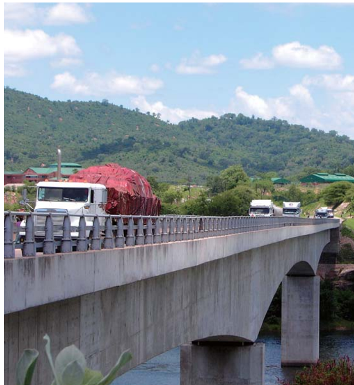
日本の無償資金協力で2002年に完成した新チルンド橋を渡るトラック
