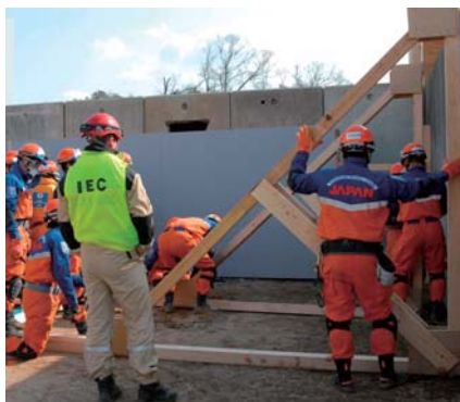
国内の救助活動で正式導入されていない「ショアリング」（建物の倒壊を防ぐ技術）も試験項目の一つだった
