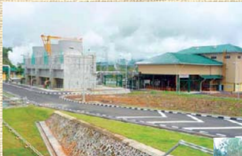
円借款で北スラウェシ州ラヘンドン地区に新設された地熱発電所
