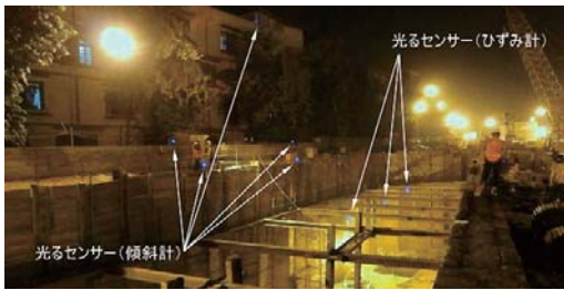
デリー・メトロ建設現場に取り付けられたOSV。数カ所に分かれ光るセンサーが設置されている
