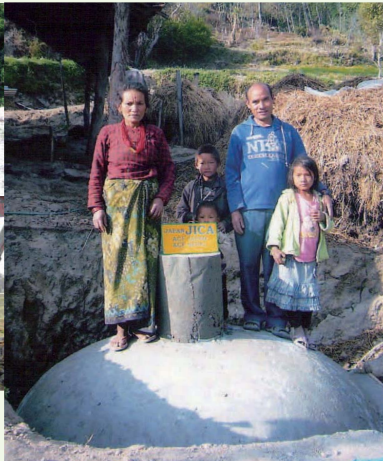
バイオガス装置を設置した家庭。トイレからこの装置に流された糞を水と混ぜてガスを発生させる
