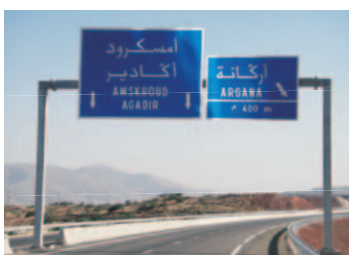
JICAが建設に協力した「マラケシュ-アガディール間高速道路」
