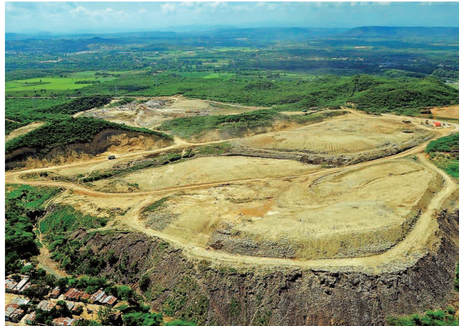
改修前のラフェイ処分場(右)は白煙と悪臭がひどく、住民からの苦情が相次いでいた。「福岡方式」の導入によりエコパーク・ラフェイ(左)として再生し、今では環境が劇的に改善されている
