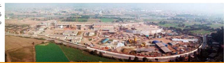
順調に工事が進むワチパ浄水場。すぐ隣にあるリマック川では、取水堰も建設されている
