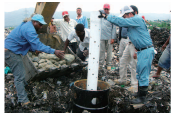
重機で穴を掘り、ガス抜き管を設置する清掃公社の職員と調査団のメンバー。発火防止を図るためのものだ
