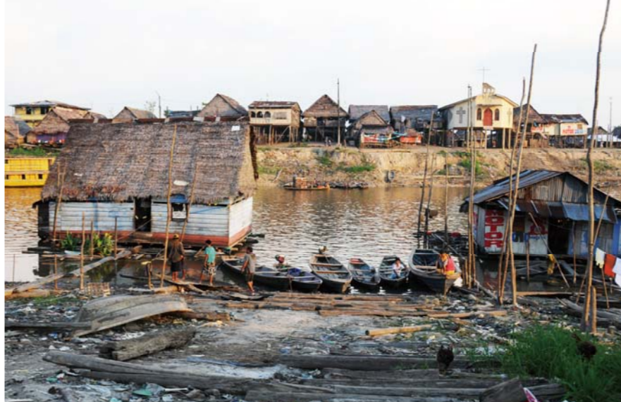
イキトス市内ベレン地区には地方出身者が多く暮らす。特にこのような低地の地域では、乾期にはこうして水が引いた状態の川も、雨期になると水位が急上昇し、高床式になっている家屋(写真奥)の1階部分は浸水する(手前の家屋のように船上家屋も少なくない)。上下水道整備は今後の大きな課題だ
