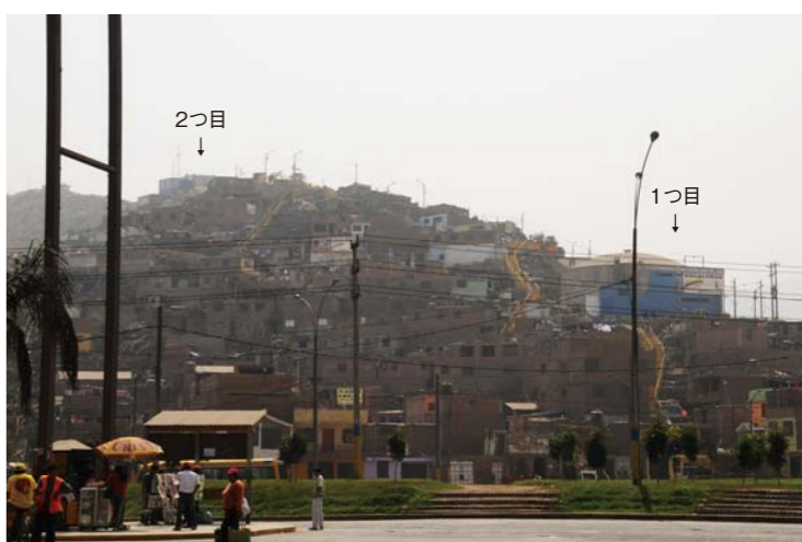
丘の上のある地区では、1つ目の給水タンク（右）を建設後、それより高い位置に家が建ったため、SEDAPALは2つ目のタンクをさらにその住宅地よりも上に設置（左）
