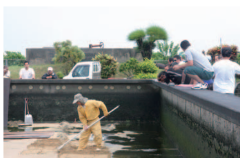
ろ過池のろ過砂かき取り作業を見学する研修員たち
