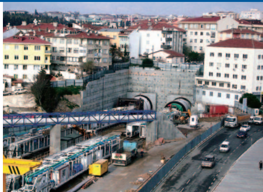
上層と下層で流れの向きが変わるボスポラス海峡でのトンネル工事は、高度な建設技術が求められる
