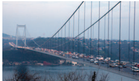
ボスポラス海峡に架かるボスポラス橋。慢性的な交通渋滞に市民は悩まされている
