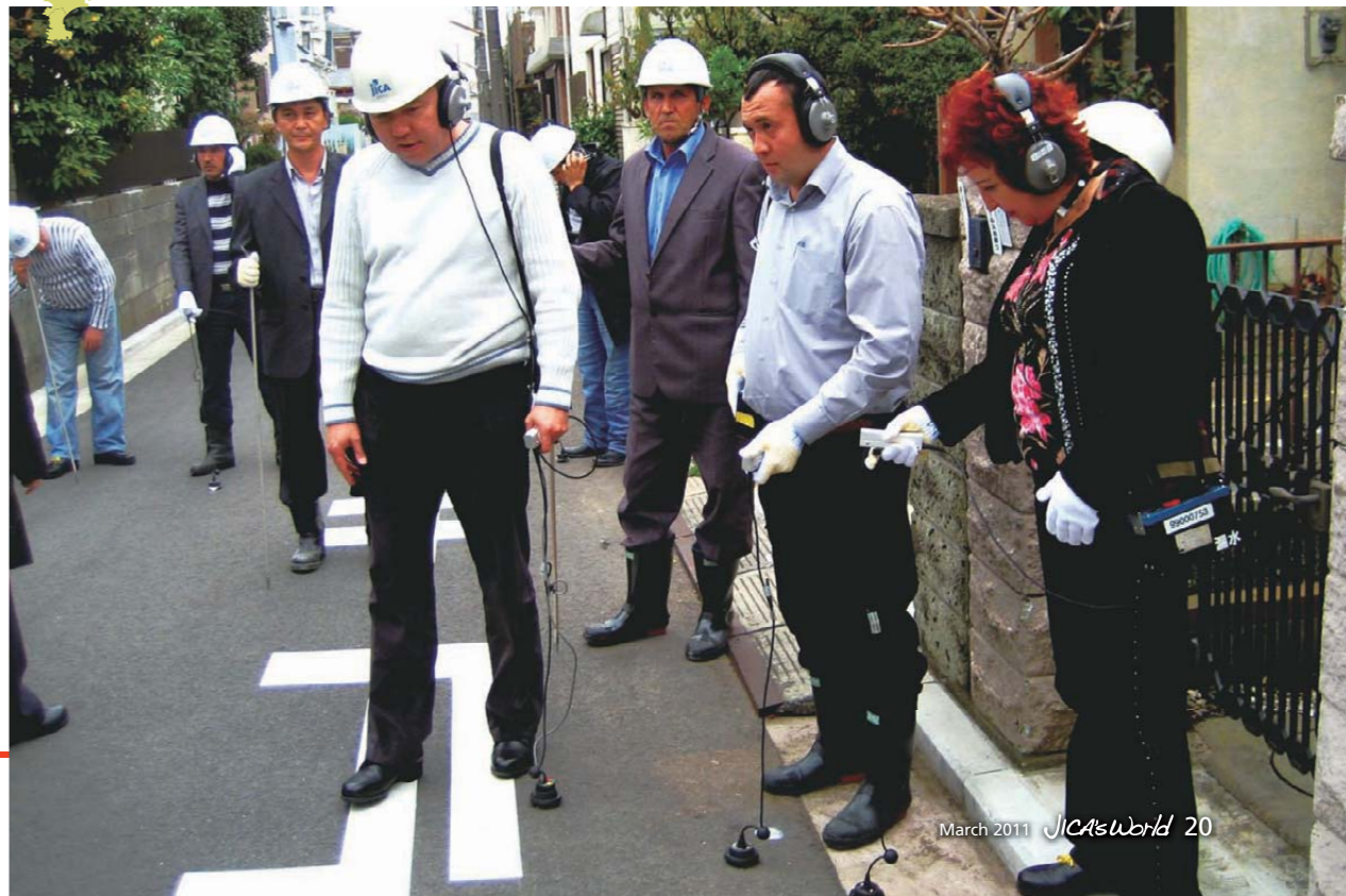
2010年11月には、JICAの研修「中央アジア地域中小規模都市給水」を受け入れた横浜ウォーター。漏水探知機で、排水管からの漏水の有無を確認する
