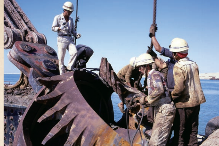
船のかじの先端に取り付けられた直径約3メートルのカッターの交換作業。54本の刃先(カッターチップ)が、スエズ運河の可能性を切り開いていった
