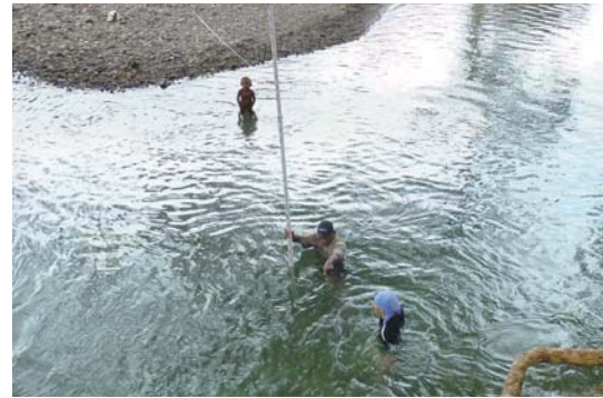
水資源局の職員と川の測量を行うJICA専門家(右)。収集したデータは、今後の洪水対策に生かしていく
