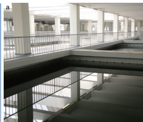
※自動式の急速ろ過装置。
