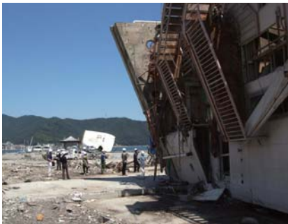
「津波防災」コースの研修員は、宮城県女川町などを訪れ、港近くの津波被災状況を視察した
