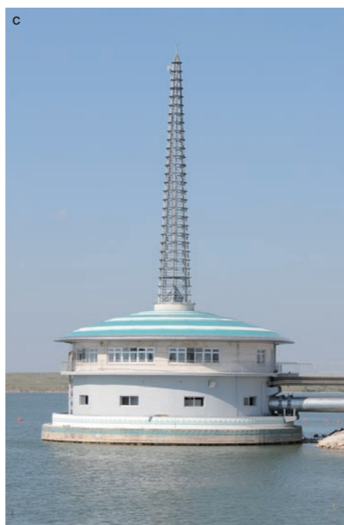
a. 円借款で新設された浄水場。ろ過装置には、荏原製作所の特許技術が使われている b. 新浄水場の制御室。大型パネルで場内の状況がひと目で分かり、異常が発生した箇所は赤く点滅する設定になっている c. 市の中心から約50キロ南東にある貯水池に円借款で建設された取水塔。取水量などのデータは、レーダーで街なかにある浄水場の制御室に送信される仕組みになっている d. アスタナ市水道公社のドゥサイエフ総裁（右）は、日本人コンサルタントと毎週のようにミーティングで顔を合わせており、下藤さんとは腹を割って話せる仲
