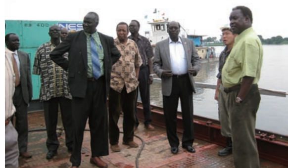
河川港の栈橋の建設現場を視察する現地政府の行政官たち
