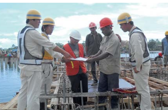
[上]アウキ市場の建設現場。整備が進めば衛生的に生鮮品を販売でき、消費者の安心も高まる
