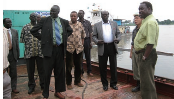
河川港の橋の建設現場を視察する現地政府の行政官たち
