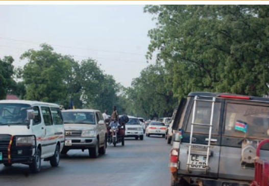
2007年には土道だった街中の道路(上)。CPA後に配分された石油収入により整備が進み、現在は交通量も増えて渋滞が発生するまでになった(下)
