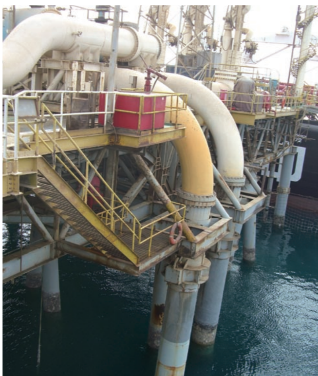
海底に敷設されたパイプラインがオイルターミナル上の出荷設備につながっている
