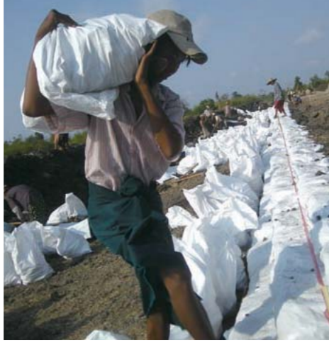
サイクロン・ナルギスで被災したデルタ地帯では、農業生産の回復に向け、堤防の修復などを通じた支援を行っている
