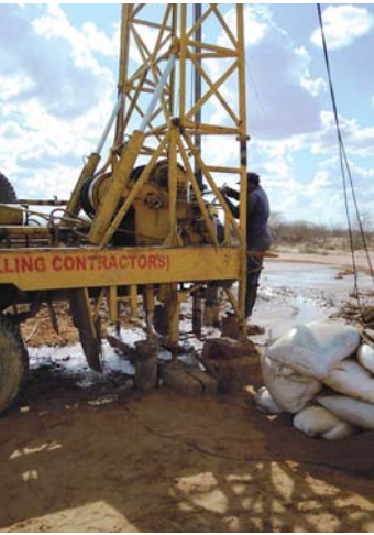
[上]ダダブ難民キャンプのホストコミュニティでも水不足が深刻。枯れていない井戸には住民が集中する [下]井戸を建設するため、掘削機で地中の水源まで穴を掘っていく
