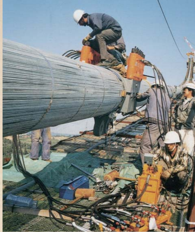
橋げたをつるための部品を一つ一つ確認しながら取り付ける
