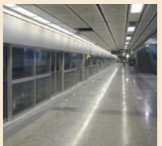
転落防止のため、ホームドアが設置されたバンコク地下鉄
