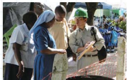
レオガン市内の学校で公共水栓の設置について話し合うJICA専門家
