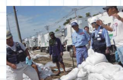
日本人技術者の指導の下、排水ポンプ車を使って排水作業が進められた
