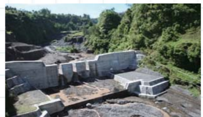
メラピ山に建設された砂防ダム
