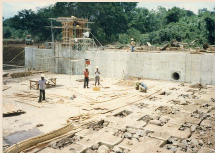
ローア・モシ地区で取水施設の建設に取り組むタンザニア人の作業員。「灌漑施設が整備されたことで、私たちの生活も豊かになりました」
