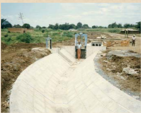
幹線水路をコンクリートを使って舗装(上)。タンザニア州では灌漑施設完成後、一期作目から大豊作だった(左)
