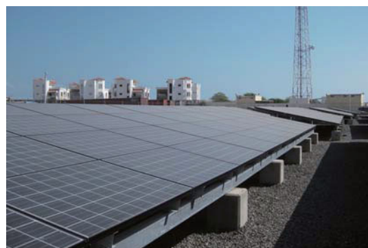
将来的な太陽光発電の普及を目指し、調査研究センターに設置されたソーラーパネル
