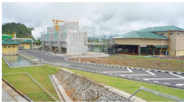
ラヘンドン地熱発電所の全景。右の建物の中に、日本の支援で作られた発電機が据え付けられている
