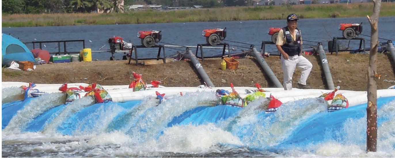
昼夜を問わず行われた排水作業。32日間で東京ドーム6.5個分の水が除去された
