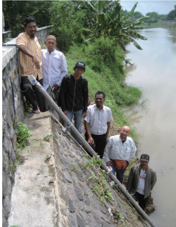
ブラントス川に水位計を取り付けた地元住民と尾島さん(右から二人目)。この日は堤防を土のうで補強する作業も行われ、「人の命を守る活動にかかわれることにやりがいを感じる」と尾島さんは話す
