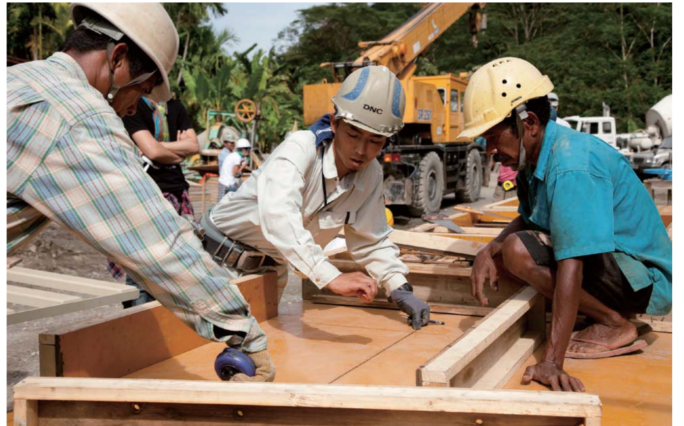
洪水により導水管が破損したディリ西部では、日本の無償資金協力により給水施設緊急改修工事を実施。独立前からインフラ整備への支援を続けてきた日本の技術者への信頼は厚い（撮影:久野真一）
