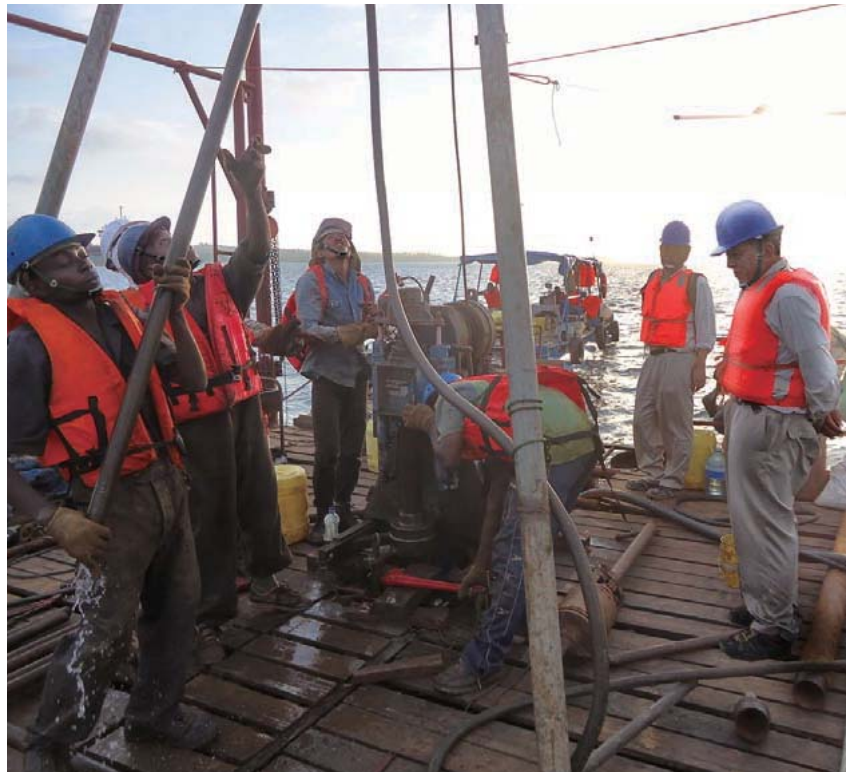
新コンテナターミナルの建設予定地で地盤のボーリング調査を行う山谷所長(右端)
