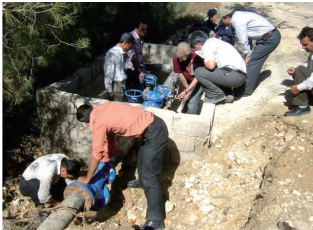
水圧が高すぎる場所には圧力を調整する装置を設置。水道庁職員も現場の作業に携わる
