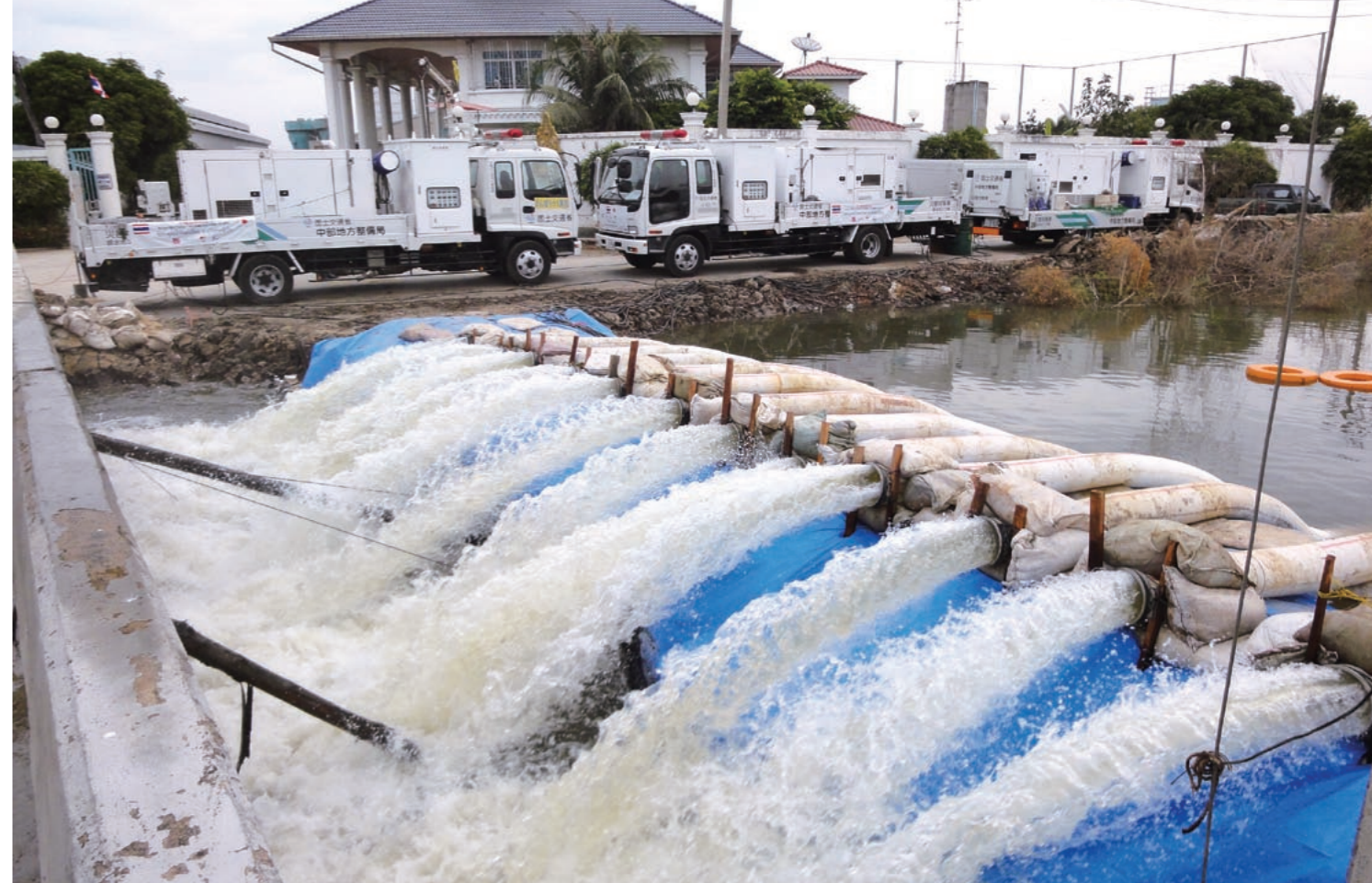
首都の北西に位置するサイノイ村の住宅地。日本から出動した排水ポンプ車を使って堤防の外へ勢いよく排水作業を行う
