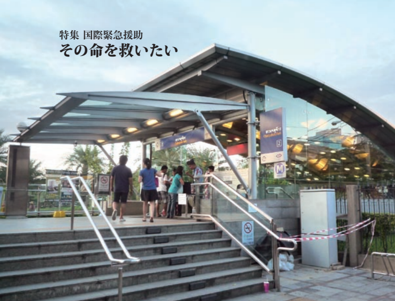
洪水対策として、海拔2メートルに設置されているバンコク地下鉄の入り口
