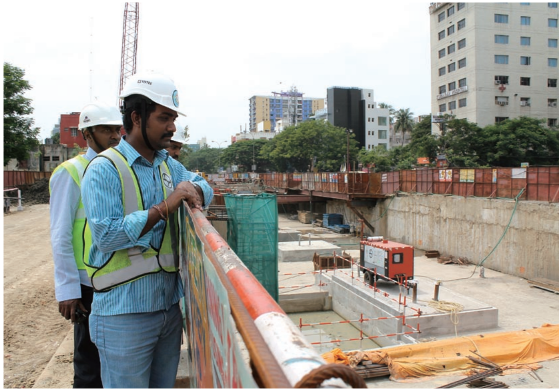
地下の駅となるネルパークの工事現場。安全管理を促すポスターを張ることで、作業員の意識も高まってきた
