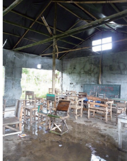
政府と反政府組織の紛争の影響で破壊された学校。人々の生活に直結するインフラ整備が進められている
